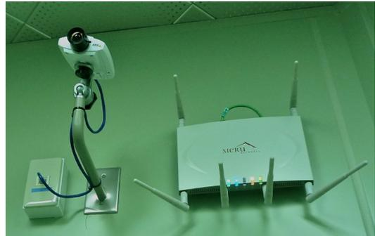
図2 IPカメラをそれまでのアナログカメラのマウントを利用して取り付けたとこ。右側の無線AP親機は第2期で取り付けたもの。
